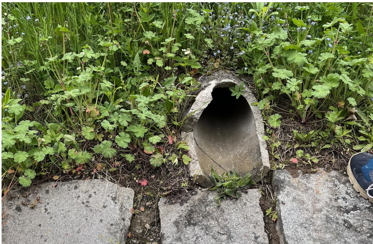
10. Úsek U2; pohled z koryta, výúst' dešťové kanalizace, beton DN 150 na PB
