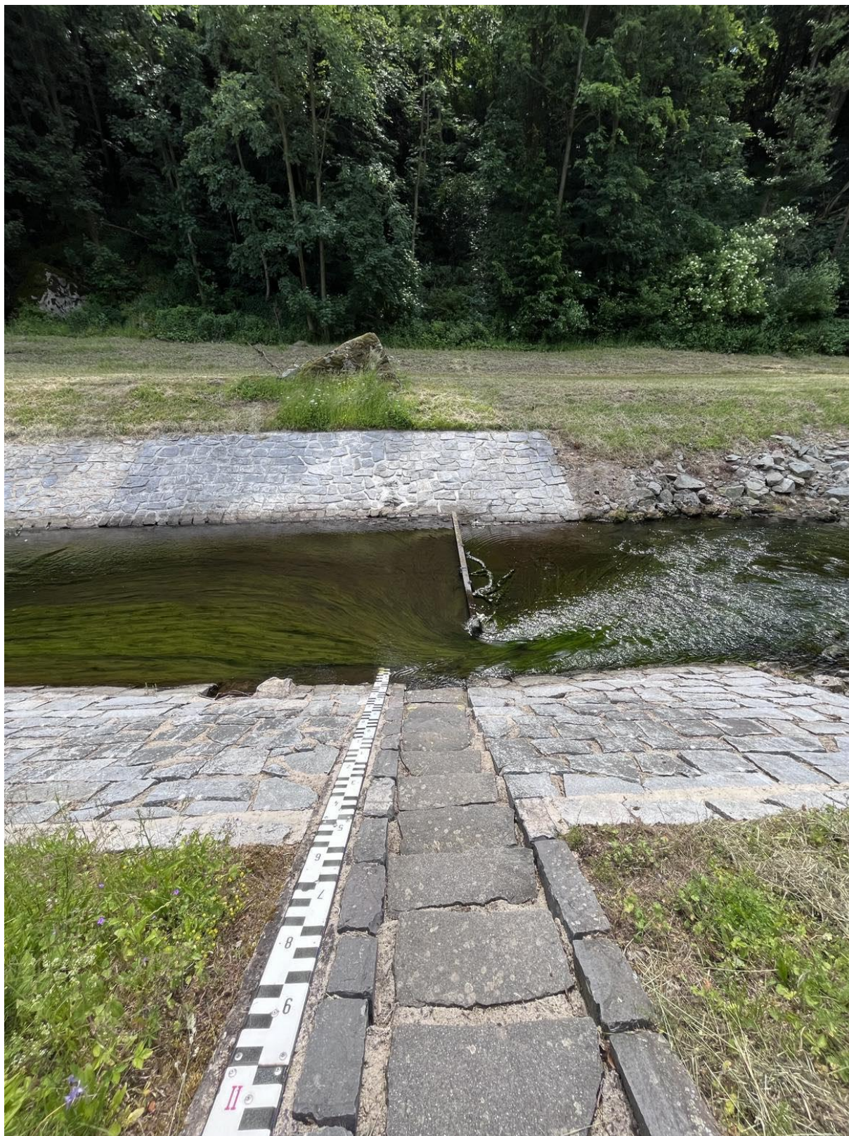
9. Úsek U2; pohled z PB na schodiště, vodočetnou lať, nátokový práh, nátokový objekt do LG stanice
