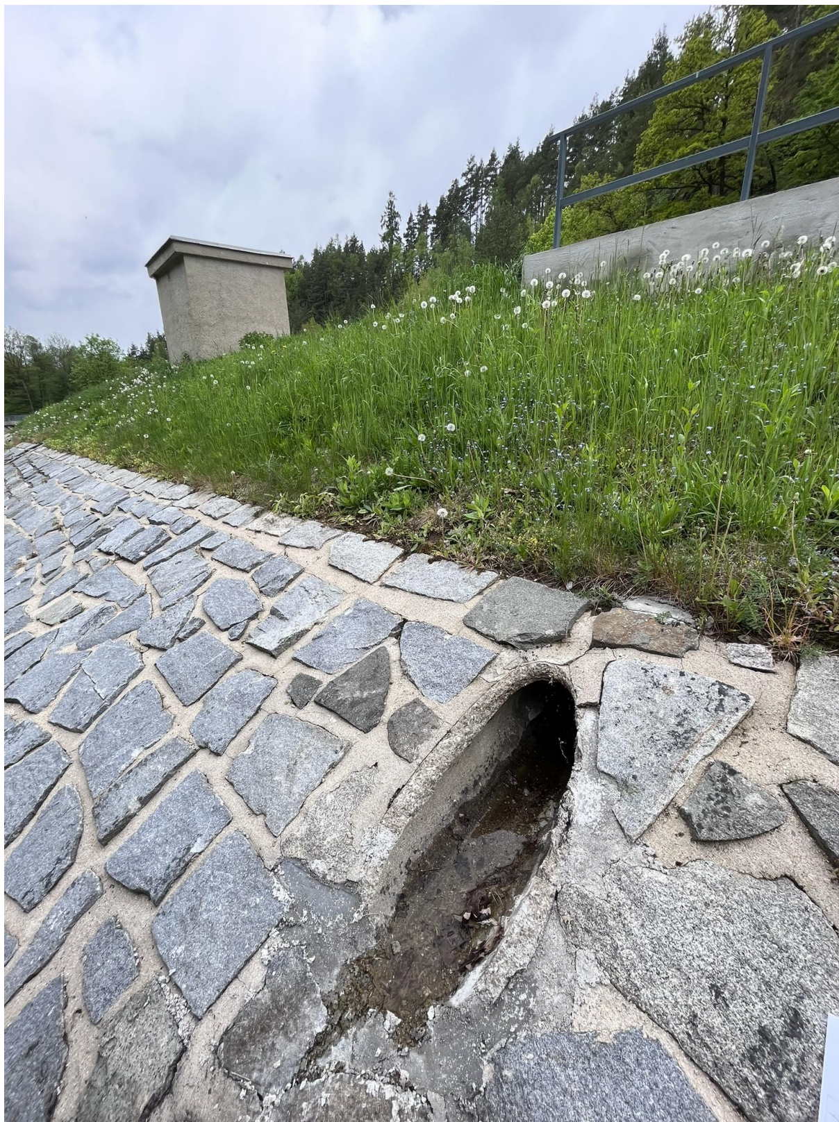
16. Úsek U3; pohled z koryta, výúst dešťové kanalizace, beton DN 300 na PB
