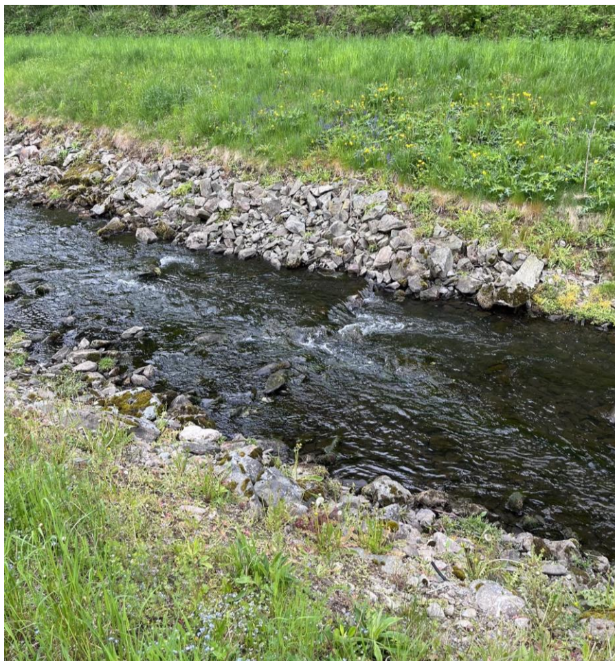
3. Úsek U1; pohled z PB, stávající břehové opevnění z LK
