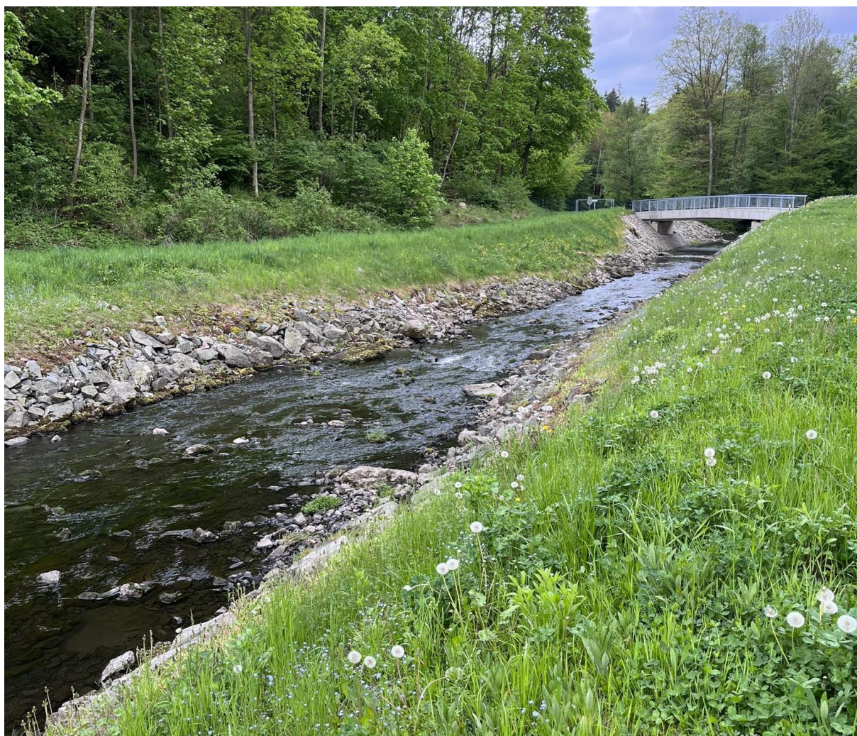
2. Úsek U1; pohled z PB po proudu, stávající břehové opevnění z LK
