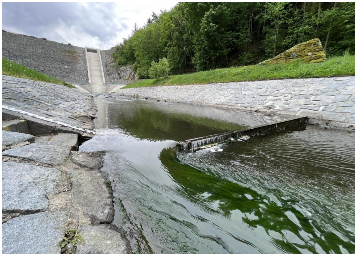
6. Úsek U2; pohled z koryta proti proudu, nátokový práh do limnigrafické stanice
