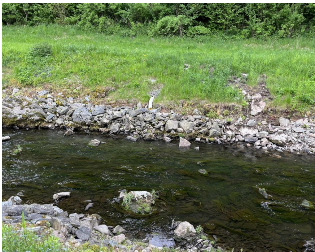
3. Úsek U1; pohled z PB, stávající břehové opevnění z LK
